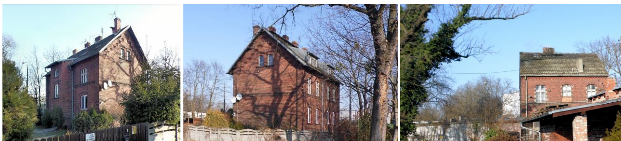
Dwa największe budynki kolejowe towarzyszące stacji
